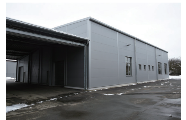
ドライ真空ポンプのオーバーホール工場
