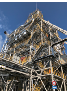
ソヤノウッドパワー株式会社向け木質バイオマス発電所
